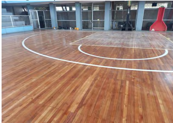
TRABAJOS DE CAMBIO DE DUELAS DAÑADAS, LIJADO TOTAL, MASILLADO, LAQUEADO, TRAZADO DE LINEAS, LAQUEADO Y PINTADO DE LA CANCHA DE BALONCESTO INCLUIDO ESCUDO DE FEDEORO.
