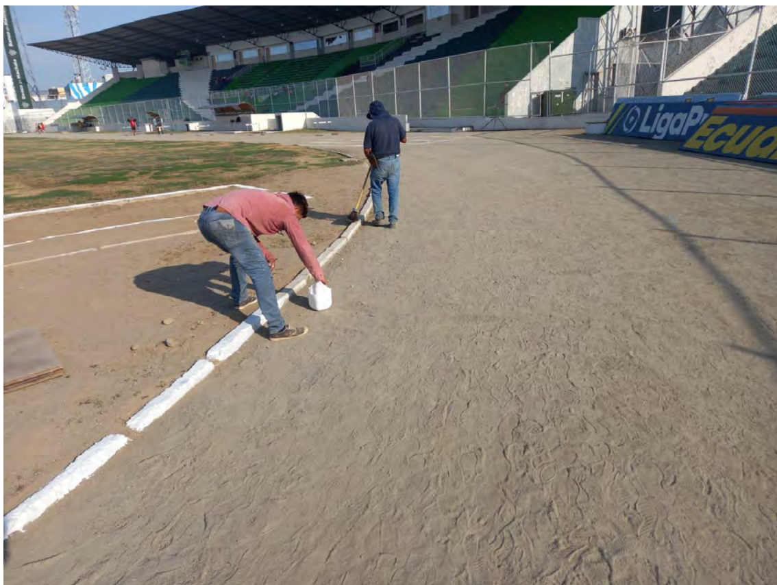
PINTADO DE LAS LINEAS Y PISTA DE 400 METROS Y AREA DE SALTO
