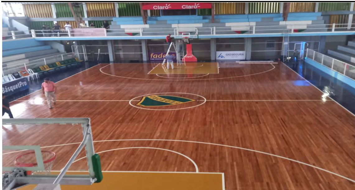
TRABAJOS TERMINADOS EN EL PARQUET E INSTALACION DE TABLEROS.
