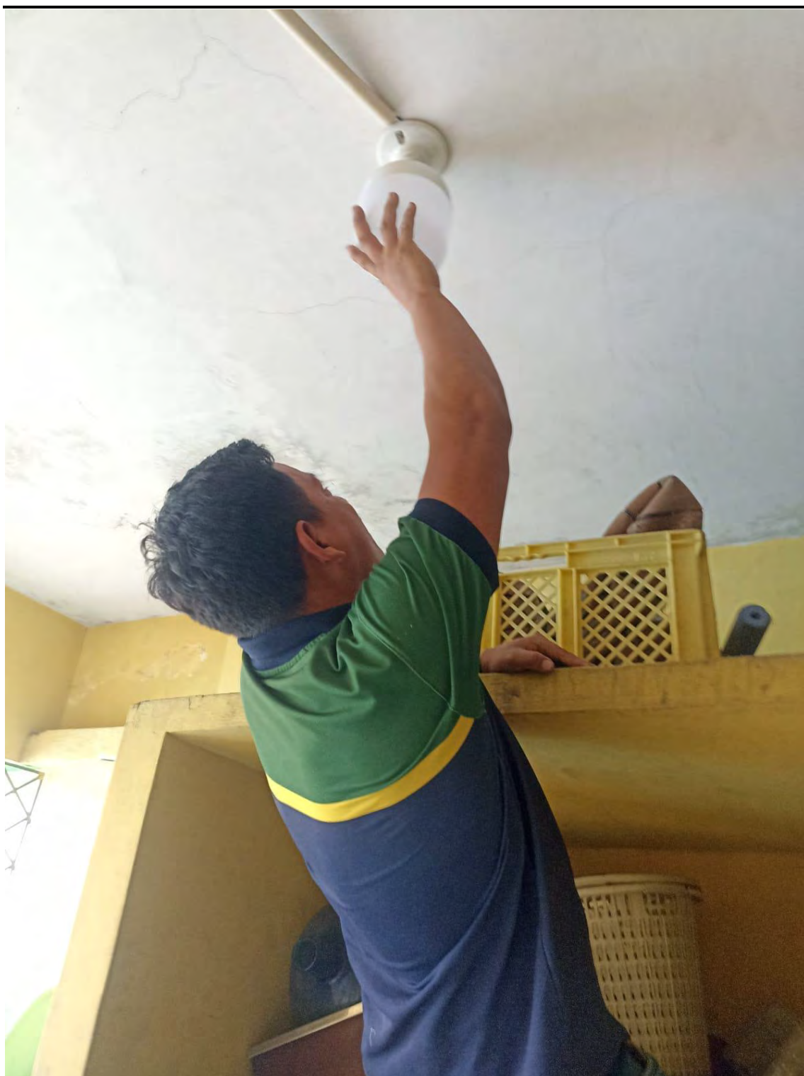
PERSONAL DE FEDEORO INSTALADO LOS FOCOS. Diciembre 2024.
