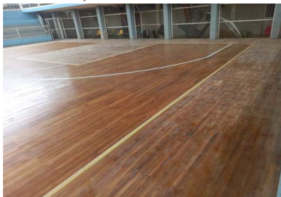
TRABAJOS DE CAMBIO DE DUELAS DAÑADAS, LIJADO TOTAL, MASILLADO, LAQUEADO, TRAZADO DE LINEAS, LAQUEADO Y PINTADO DE LA CANCHA DE BALONCESTO INCLUIDO ESCUDO DE FEDEORO.
