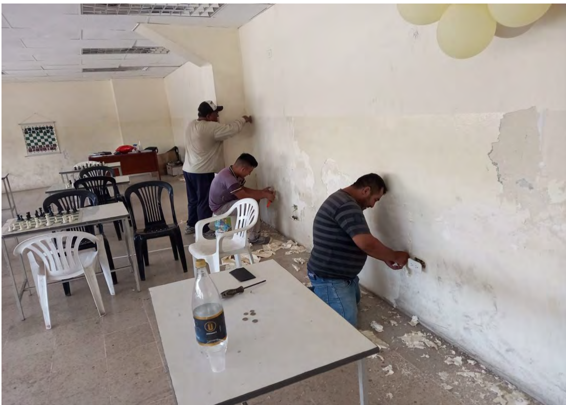
Personal de Fedeoro realizando trabajos de pintura área Ajedrez.
