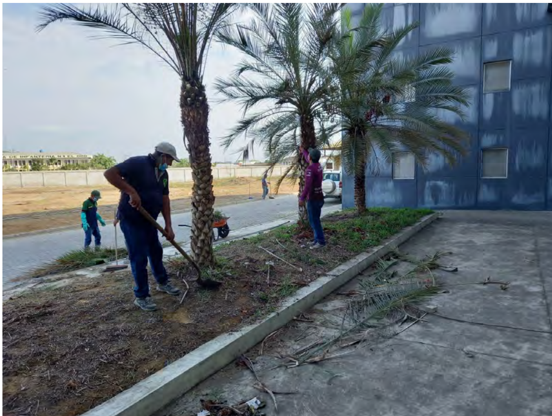
TRABAJOS DE MANTENIMIENTO Y LIMPIEZA DEL AREA EXTERIOR DEL COLISEO POLIDEPORTIVO MACHALA 3000
