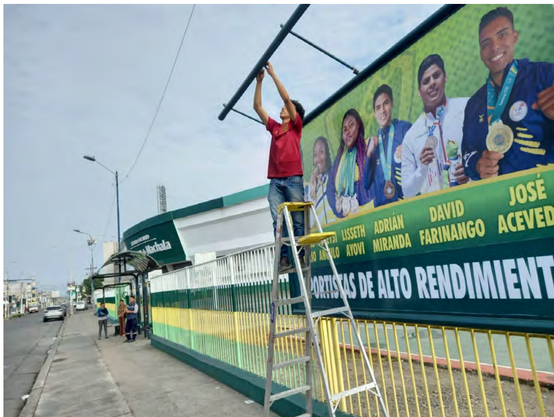
TRABAJOS DE REPARACIÓN DE SISTEMA DE ILUMINACIÓN GALERÍA DE CAMPEONES UBICADO EN EXPLANADA ESTADIO 9 DE MAYO. DICIEMBRE 2023.
